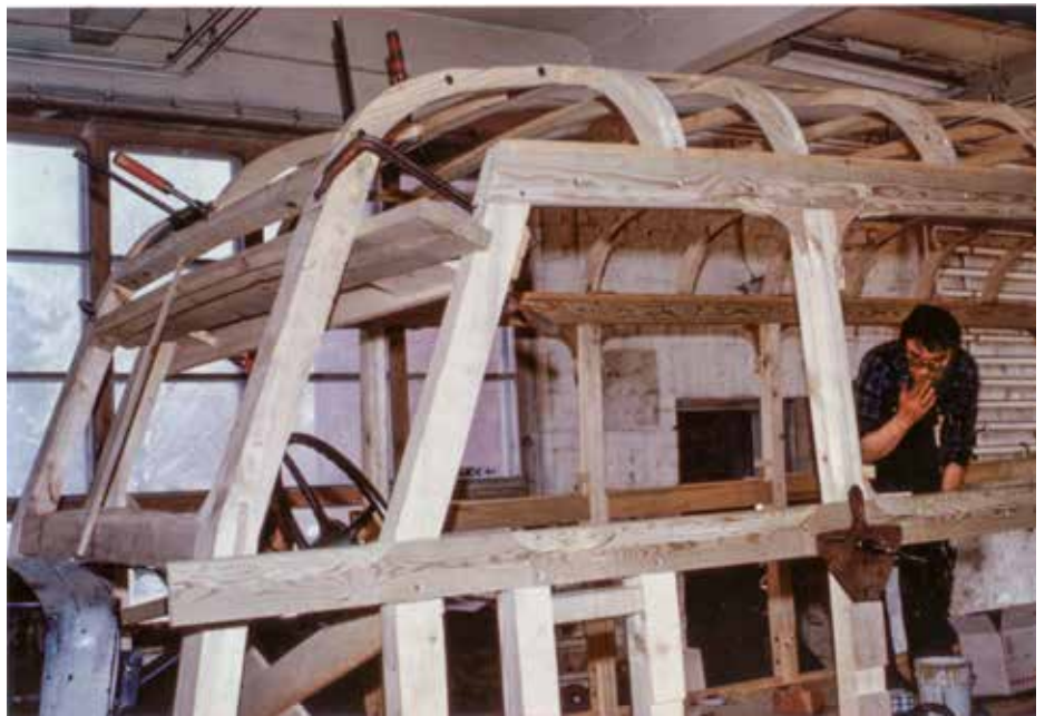
Kattokaaret on asennettu korikehikkoon ja tuulilasien aukot alkavat hahmottua.
