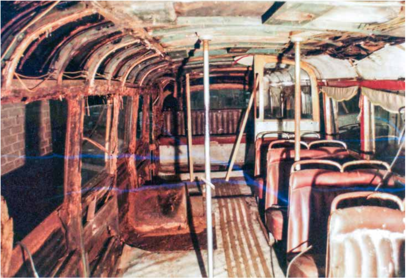
Kuljetuksen aikana osittain romahtanut katto tuettiin lisävaurioiden välttämiseksi.
