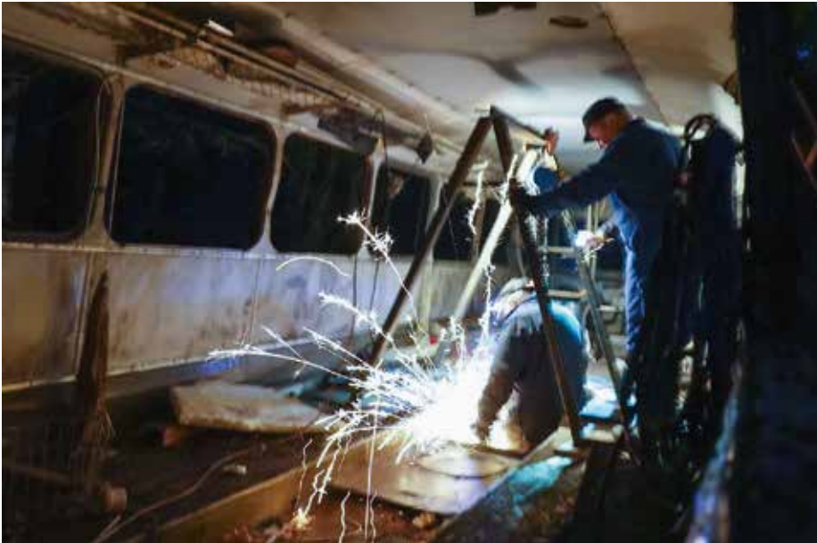
Vaihteiston irrottamiseksi autosta yläkautta, jouduttiin hiomalla katkaisemaan alustan kiinnitispalkkeja.
