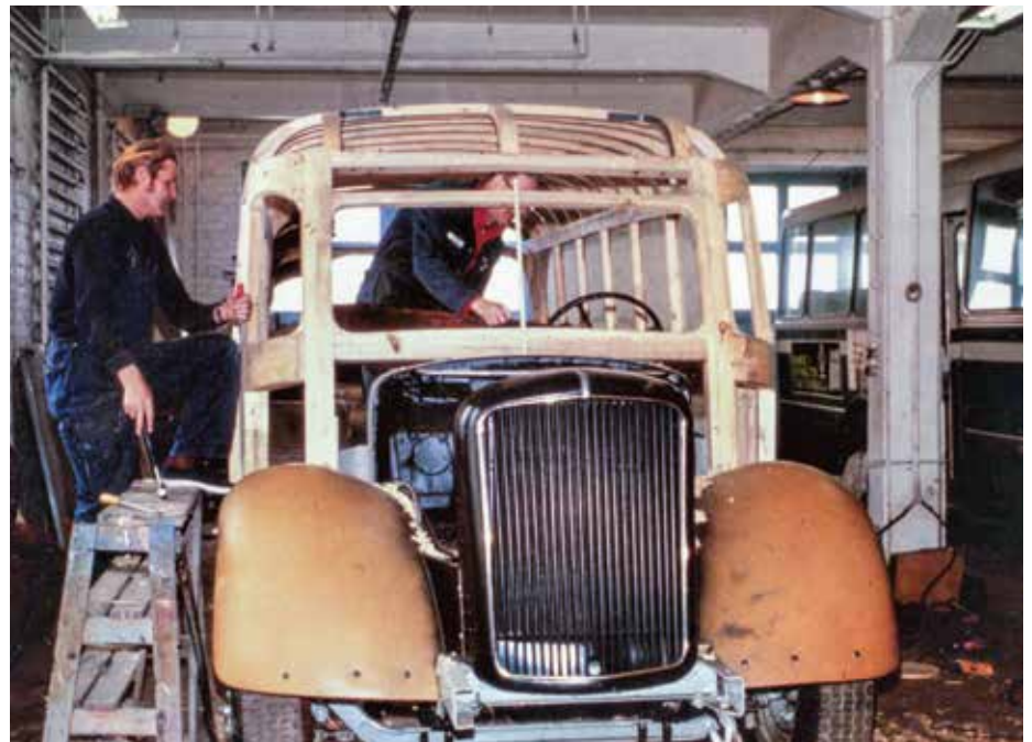
Puuseppä Kalevi Nurminen (auton ulkopuolella) viimeistelee korikehikon puurakenteita.
