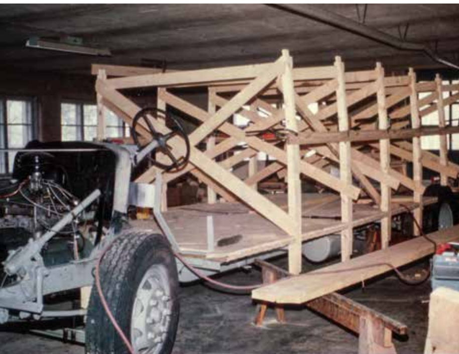
Korikehikon pystypilareissa käytettiin työnaikaisia vinotukia suoruuden varmistamiseksi.
