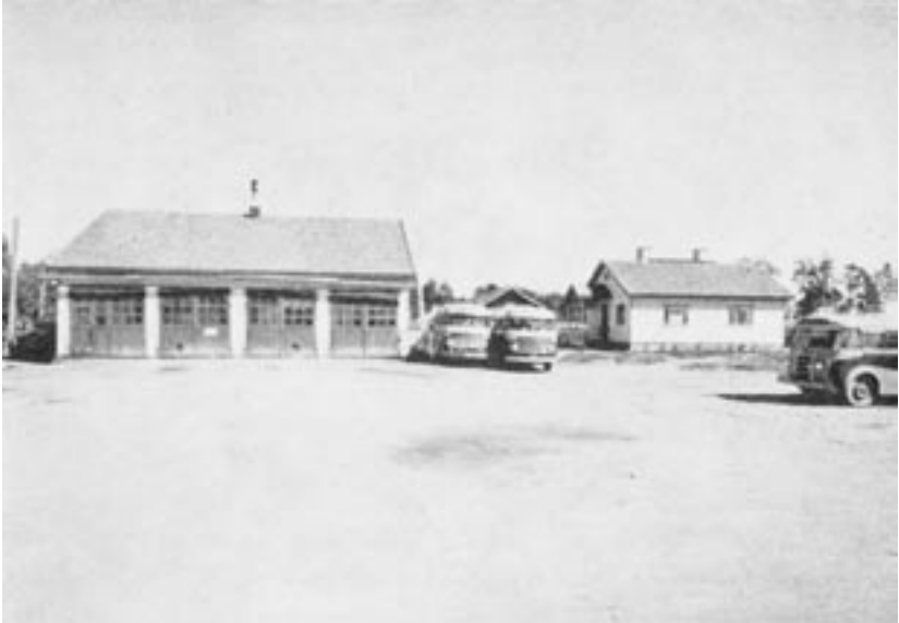
Vuonna 1944 Kuopioon valmistunut M. Ruponen Oy:n haalokorjaamo ja konttori. Vakituista henkilöstöä toimii täällä. 11.
