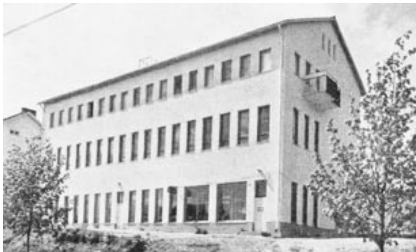
Yhtiön omistama toimitalo Savonlinnassa Heikinpohjantien varrella, jossa yhtiön toimistot ja Auto-Bruunin myymälä konttoreineen sijaitsevat.
